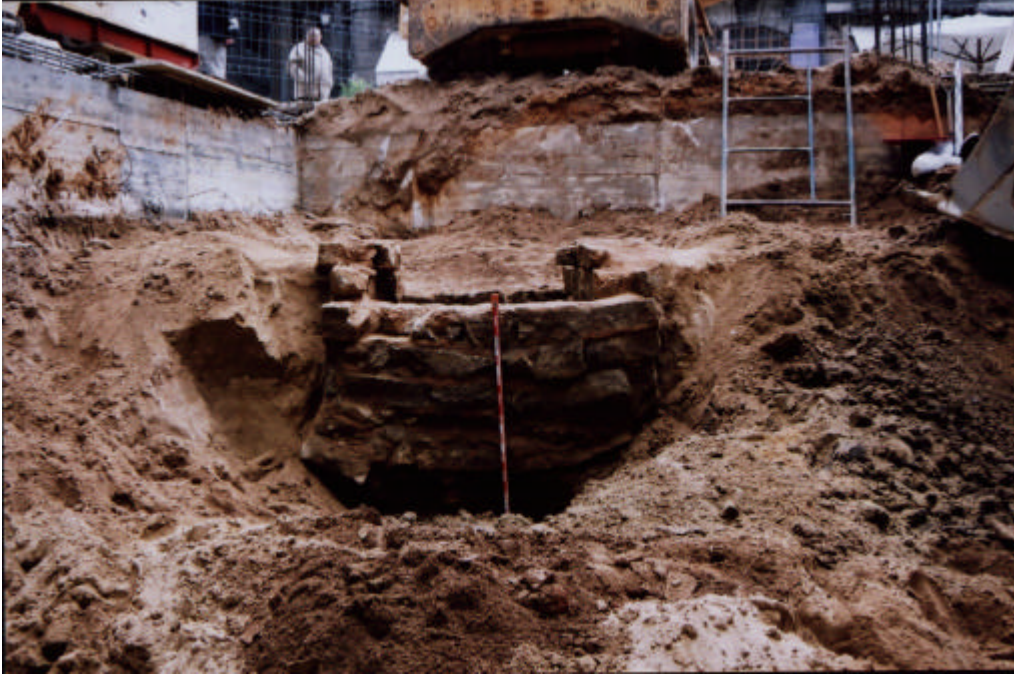
Foto 5 Vista externa del mur sud.
