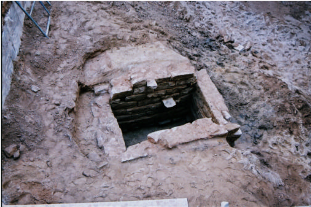
Foto 6 Vista general de l'estructura un cop excavada.
